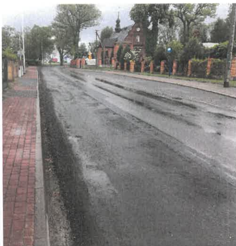
Zdjęcie 3 Widok ogólny stanu nawierzchni po wykonanych zabiegach naprawczych – miejscowość Złotków
