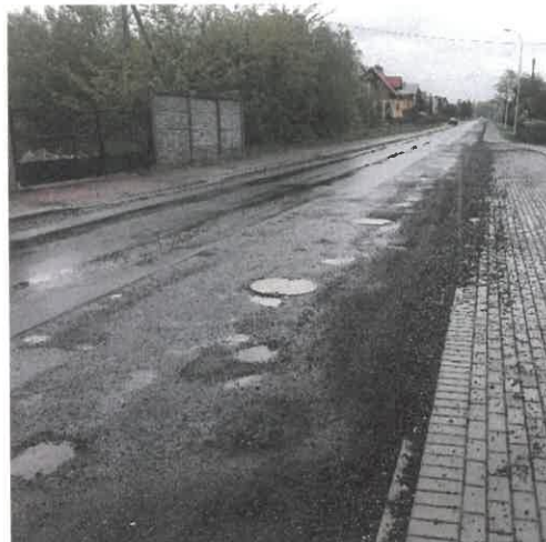
Zdjęcie 2 Widok ogólny stanu nawierzchni po wykonanych zabiegach naprawczych – miejscowość Złotków
