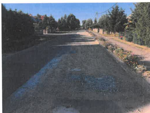
Zdjęcie 5 Widok ogólny stanu nawierzchni drogi gminnej po wykonanych zabiegach naprawczych – miejscowość Złotków
